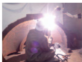
タービン車室の溶接補修
