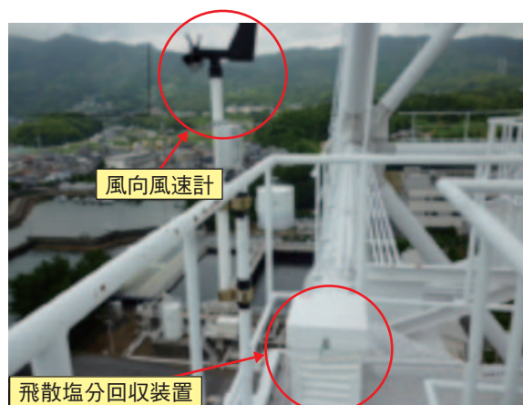
写真2 火力発電所煙突昇降階段踊場
